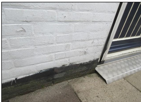
4. Afgebladderde verflaag.
