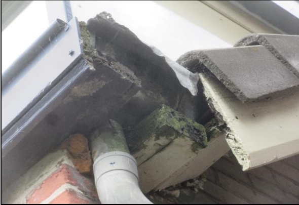
1. Ontbrekende betimmering: aanbrengen icm herstel van houtrot reparatie, zie bovengenoemd.
